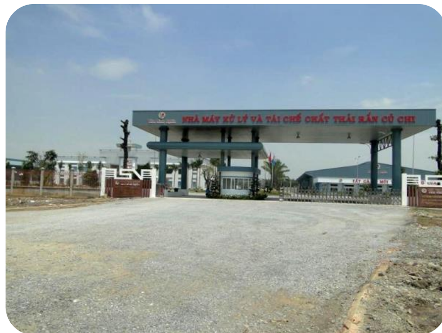
Nhà máy xử lý CTRSH – Công ty Cổ phần Tâm Sinh Nghĩa
